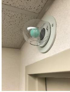
圖 8.1 壓力指示球管照片
